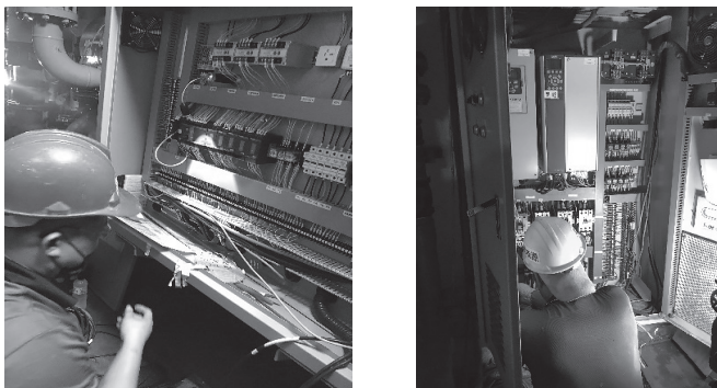
圖5 醫院現場施工照片
